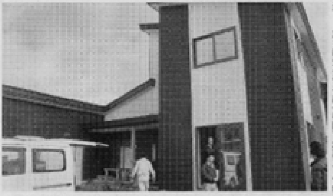
耐震診断を行った上杉に建設中の住宅
