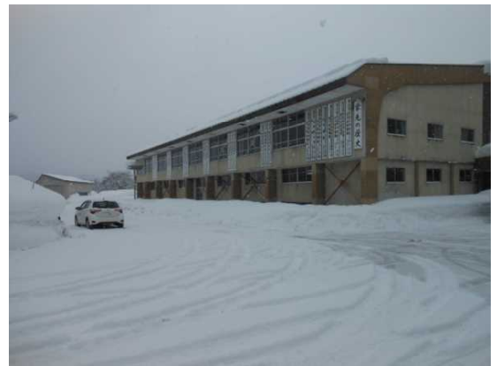
【体育館脇の落雪がたまっている様子】
